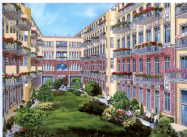
Die im Bau befindliche Wohnimmobilie in der Berliner Scharnhorststraße ist bereits ausfinanziert.
